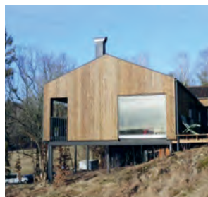
Exempel på plintgrund då markarbeten och schaktning minimeras.
