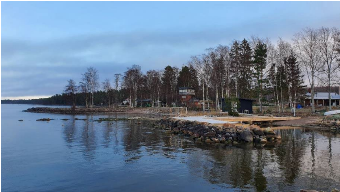
Vattenområdet mellan hamnuddan samt planområdet samt pirar norr om hamnen.
