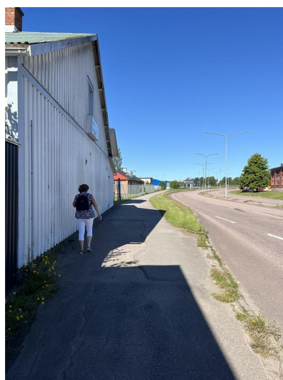
Bild: Gång- och cykelväg längs Karlstadsvägen
